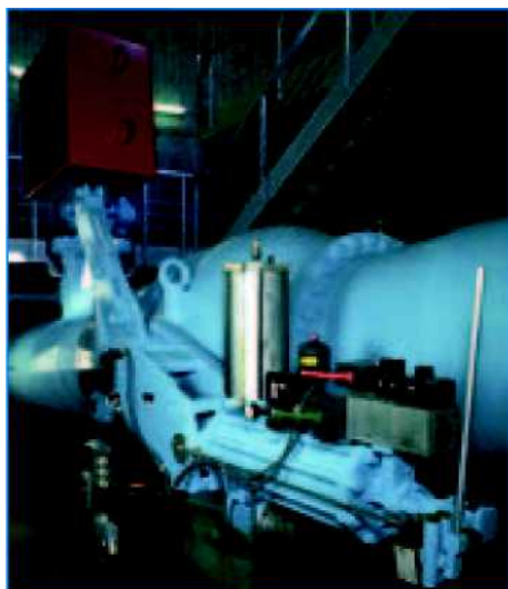
ERHARD шаровой клапан DN 800 с гидроприводом и противовесом (3 фазы)
